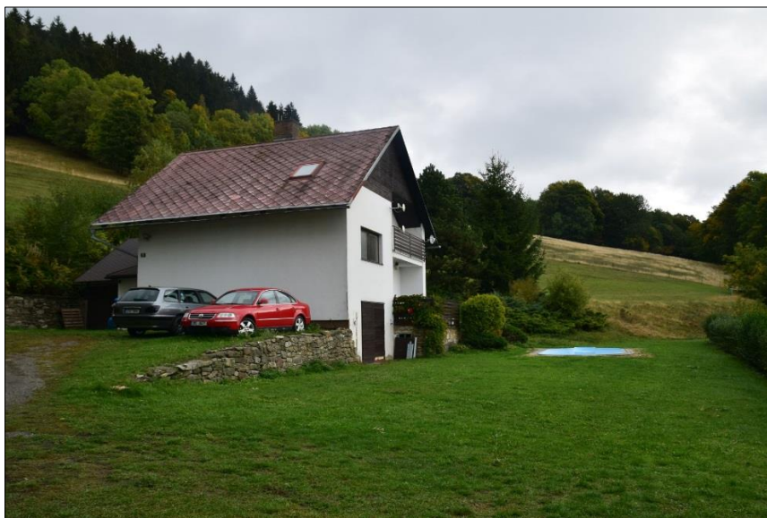
Jev č. 80: Čihákovo stavení čp. 51(zaniklé), aktuální stav foto M. Weber 2019
