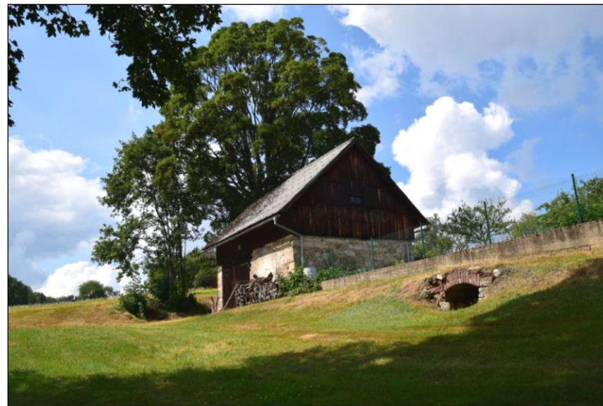
Jev č. 59: Dům U Štárů čp. 3 (zaniklý), aktuální stav foto M. Weber 2019
