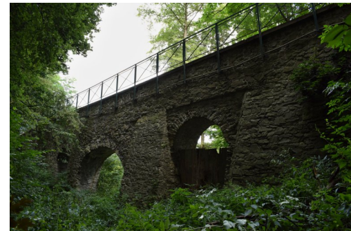
41_akvadukt Vojtěšského vodovodu.JPG
