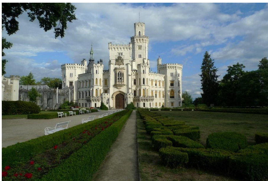
Znak 9 Zámecká zahrada - zahradně-architektonicky komponovaný areál obklopující zámek; zahrada při zámku Hluboká
