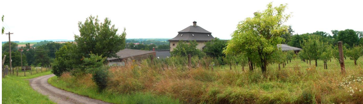
Obr. I.21: Tvrz Hradištko v pohledu ze severovýchodu ze sadů (foto FSv ČVUT 2017)
