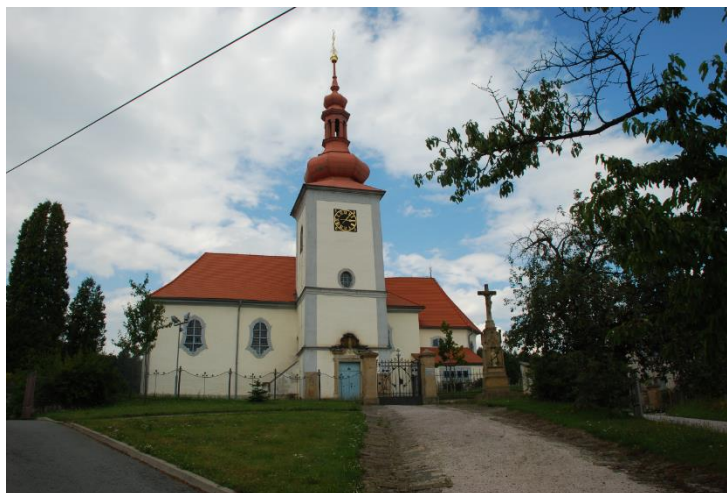
Obr. I.24: Barokní architektura kostela sv. Bartoloměje v Chodovicích s původní hranolovou věží (foto FSV ČVUT 2017).
